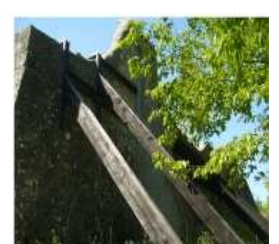
Cimitero di Casaglia. Sostegni a muro perimetrale
