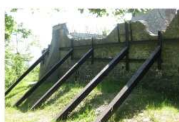
Cimitero di Casaglia. Sostegni a muro perimetrale
